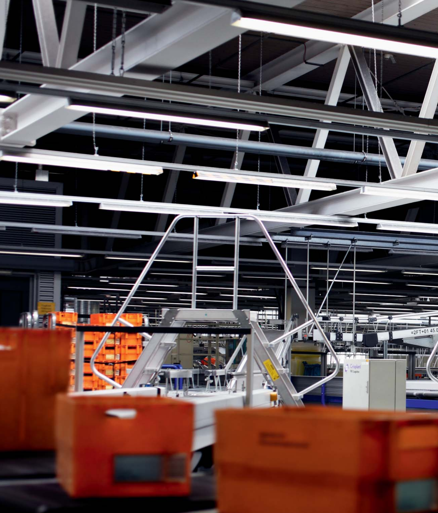
* Raiffeisen Centrobank at Österreichische Post AG (distribution center), Vienna
